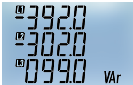
Potenze reattive di fase
